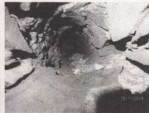
Bild 3: Bohrloch im Natursteinmw. In Zone 35 (KB 6/1)
