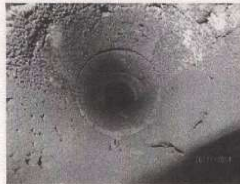
Bild 2: Bohrloch im Ziegelmauerwerk in Zone 10
