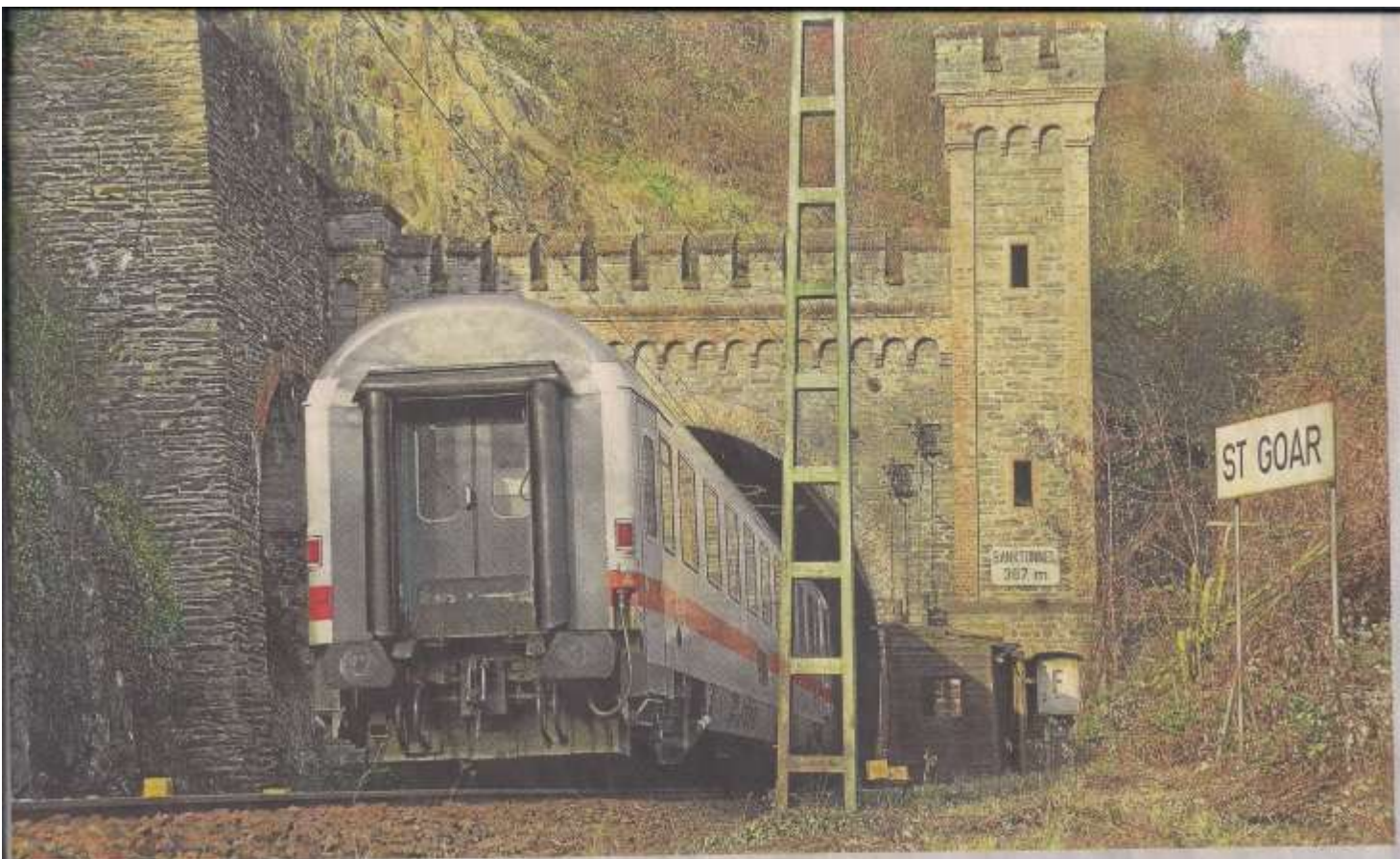
Der 367 Meter lange Bankecktunnel bei St. Goar ist ebenso sanierungsbedürftig wie die benachbarten Kammereck- und Bett-Tunnel. Welche Variante des Ausbaus oder Neubaus letztendlich zum Zuge kommt, ist noch nicht entschieden. Foto: Thomas Torkler
